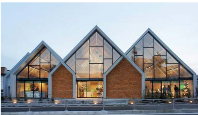
Afb. 4.70 - Baksteen en glas
